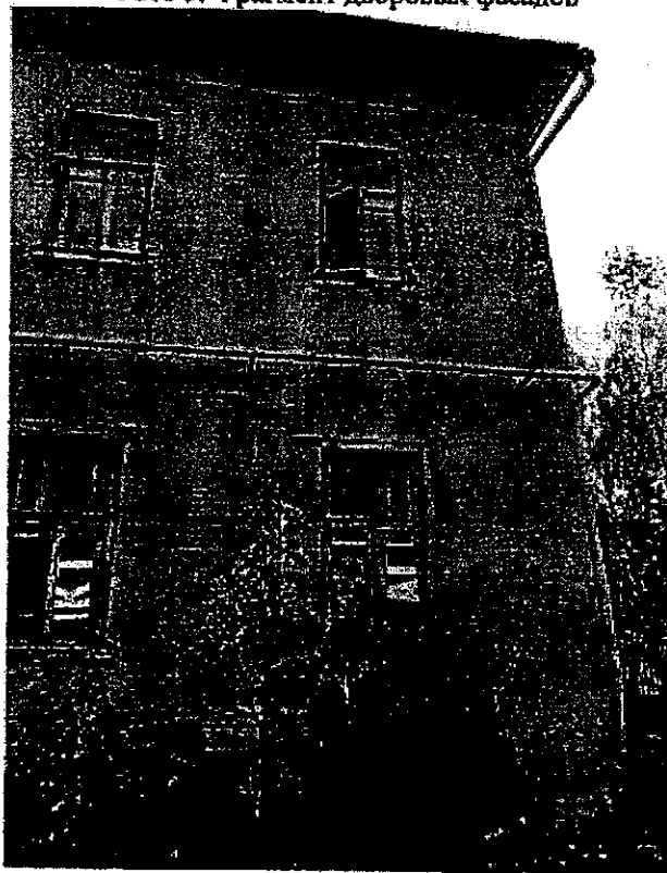
Фото 6. Фрагмент северного дворового фасада
